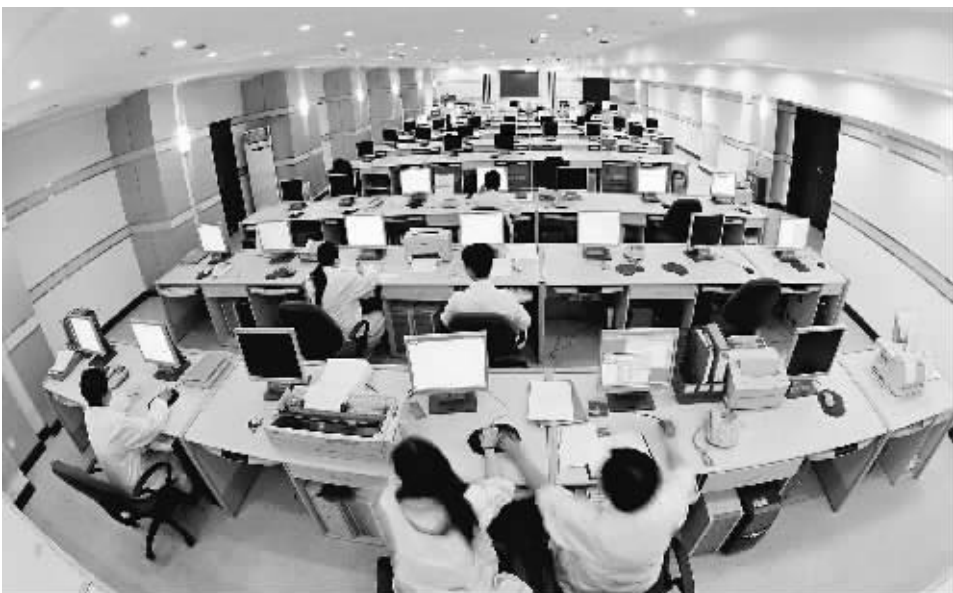
中国电信湖南分公司对长株潭地区通信运行情况进行实时监控。 胡延安 摄
