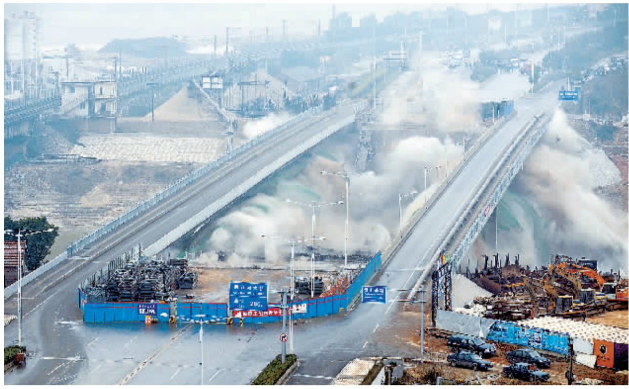
12月30日下午，位于长沙市芙蓉北路的捞刀河大桥老桥被成功爆破拆除，东西辅桥安然无恙。重建桥梁分为东西辅桥、中间主桥三座，目前东西辅桥已建成通车。
