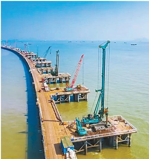
山河智能旋挖钻机在深中通道建设中大显身手。 通讯员 摄
