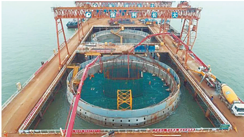
2020年3月，三一泵车为深中大桥进行大体积混凝土浇筑。 通讯员 摄
