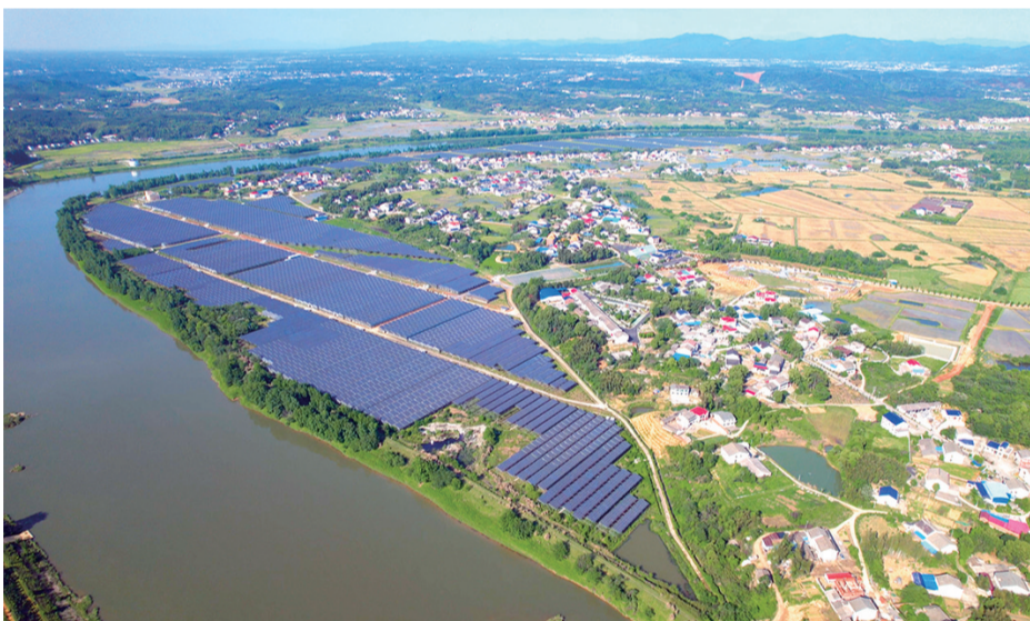
武岗村光伏产业园。
