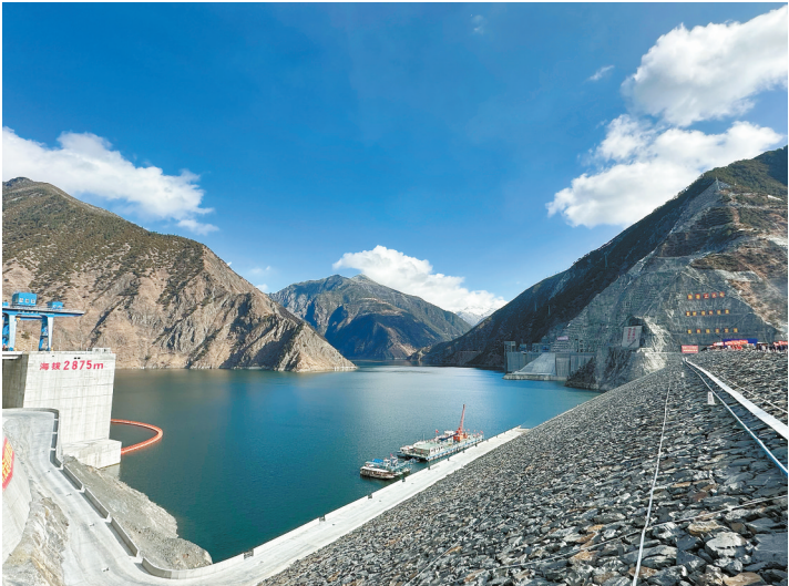
12月29日，位于四川省甘孜藏族自治州雅江县的雅砻江两河口混合式抽水蓄能项目正式开工建设，建成后将成为全球最大的混合式抽水蓄能项目。
