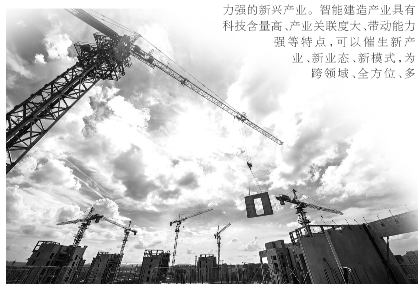
装配式建筑吊装施工现场。（本文图片由长沙市住建局提供）
