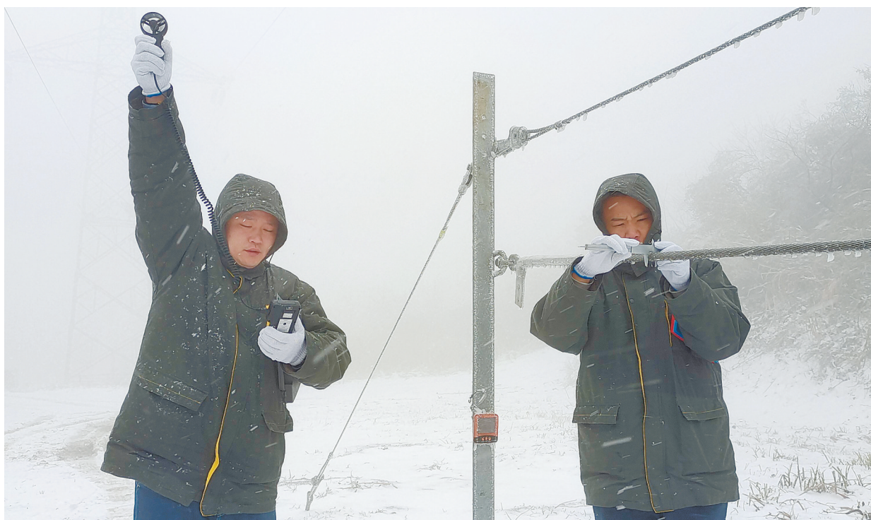
1月29日,浏阳市蕉溪岭山顶,国网浏阳市供电公司防寒融冰巡视哨值班人员正在风雪中值守检测冰情。该哨位于海拔400米高的山顶,因处于两山之间的风口,在低温雨雪天气线路极易覆冰。 曾舸 摄
