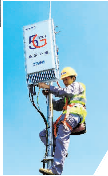
电信施工人员正在进行5G基站建设。
