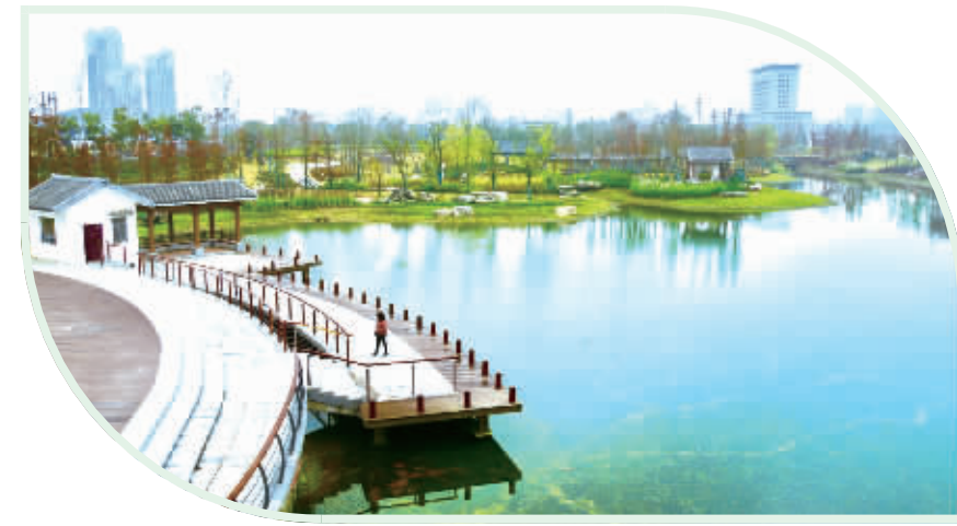
护潭二级渠黑臭水治理。 罗韬摄
