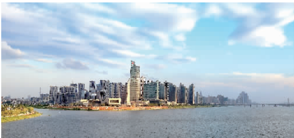
位于长沙湘江与浏阳河交汇处的北辰中信银行大厦(图中最高楼)。
