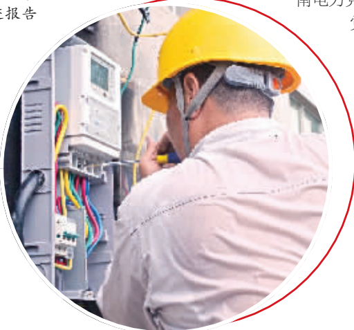
▲迎峰度夏期间，国网湖南电力员工为客户更换三相电表。
