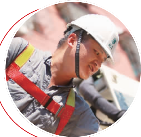
▲迎峰度夏期间，国网湖南电力员工开展带电引接作业。
