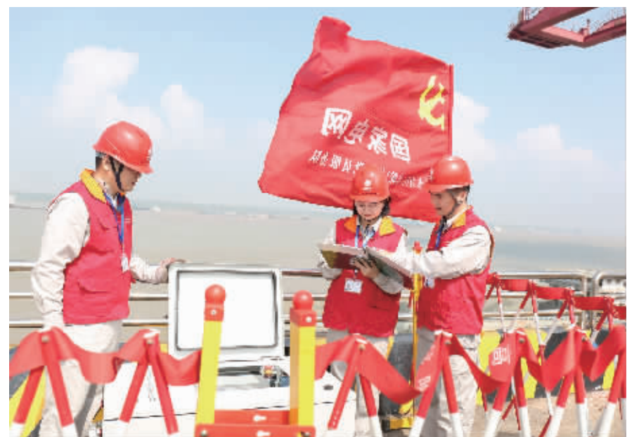
国网湖南电力“共产党员服务队”为城陵矶新港安装港口岸电装置，助力建设绿色良港。
