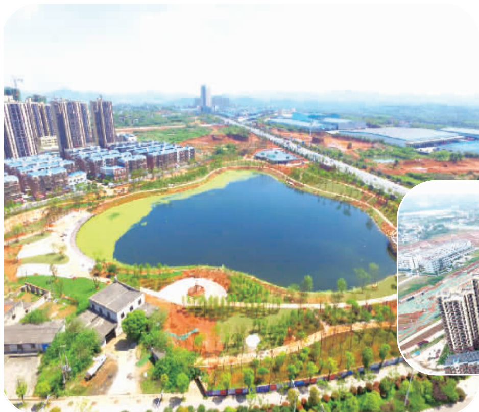
建设中的荪湖公园。 方阳 摄
