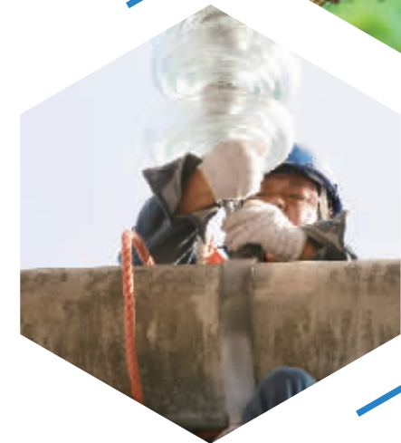
▲5月24日,郭亮变110千伏扩建施工现场。 龙莹 摄
