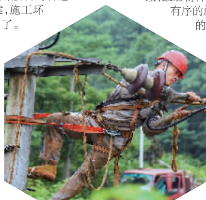
▲6月,坪塘变电站外,电力工人正在进行杆塔迁工作。 许芳 摄
