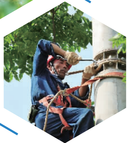
▲5月17日下午,跳马关刀新村杆线架设现场,施工人员正在紧张作业。 邓倩 摄
