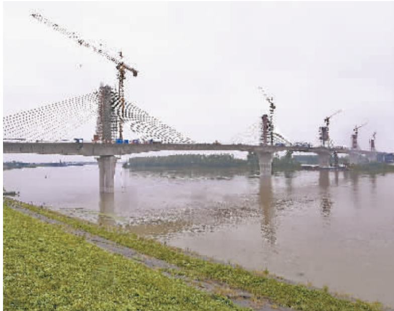
5月31日凌晨,湖南首座“五塔斜拉桥”——常德沅水四桥顺利合龙。该桥是常德市重要的综合交通枢纽,也是国道G319、G207城区段改线工程的控制性工程。
