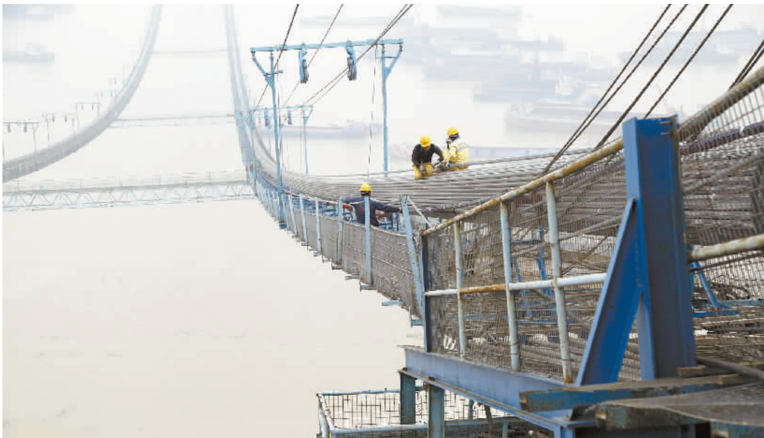
11月6日,大岳高速洞庭湖大桥施工现场,工人师傅正在进行主缆索股架设。
