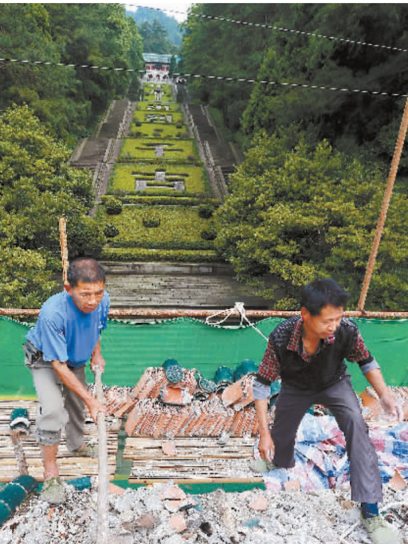
5月14日，两名工人在纪念馆屋顶施工。近日，中宣部、国家文物局、湖南省文物局拨款1420万元，对南岳忠烈祠进行全面维修，纪念抗战胜利70周年。
