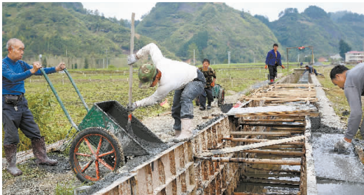
4月1日,通道侗族自治县源田蔬菜基地,工人在修建蔬菜灌溉渠和泄洪渠。近年来,该县通过创建多个标准化蔬菜生产基地,采取扩规模、建协会、提质量、创品牌、强龙头等一系列措施,壮大蔬菜产业。目前,全县蔬菜种植面积近4万亩。 刘强 摄
