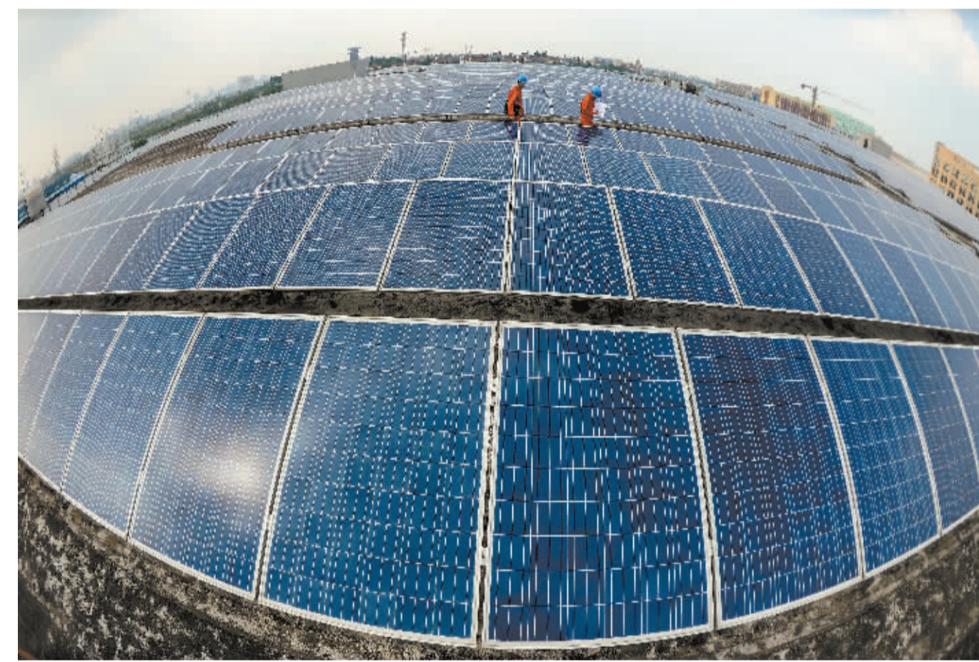
6月5日，浙江长兴县供电局工作人员在一家企业即将并网的屋顶光伏电站开展消缺工作，为并网运行做准备。 新华社发
