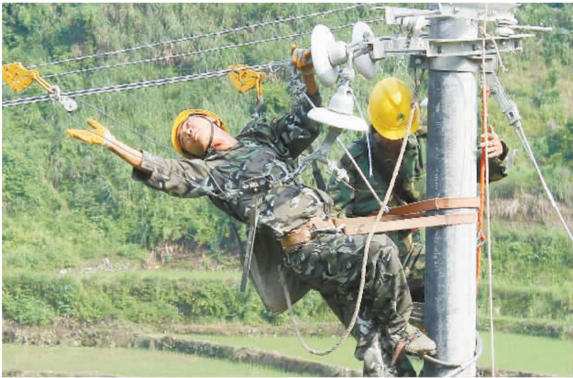
6月8日，保靖县电力公司职工在清水坪镇客寨村抢修线路。最近，当地普降大到暴雨，引发的山洪、泥石流损毁部分水利、电力等设施。该公司及时组织人员，对各乡镇电力设备进行巡查、抢修，排除安全隐患。俞采华 向洪青 摄影报道
