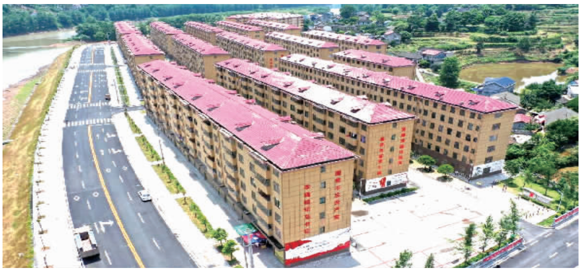
泸溪县武溪镇上堡集中安置区。
