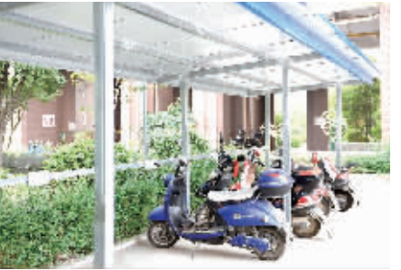
时代星空楼盘新建的电动车棚。 范远志 摄
