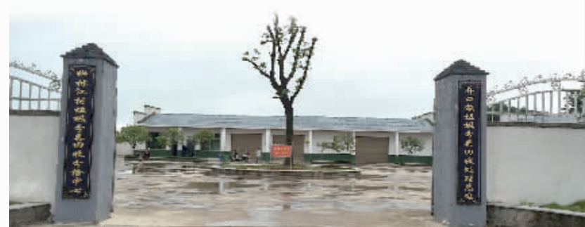
乔口镇垃圾分类回收处理总站。
