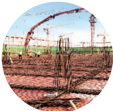
▲今年以来,长沙高新区产业项目建设跑出加速度实现新突破。图为桑德新能源项目工地,施工现场塔吊林立,一派繁忙。文玲摄
