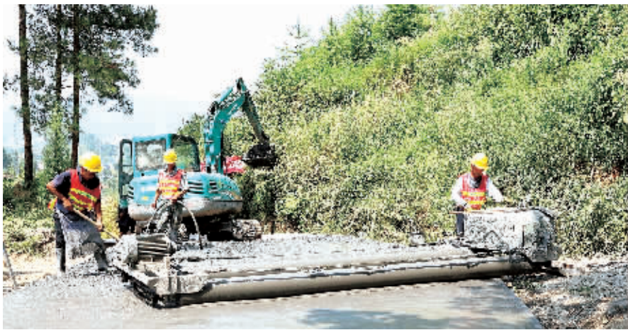
湖南交水建集团的建设者在新化县西河镇齐家村修筑水泥路。 易建东 摄
