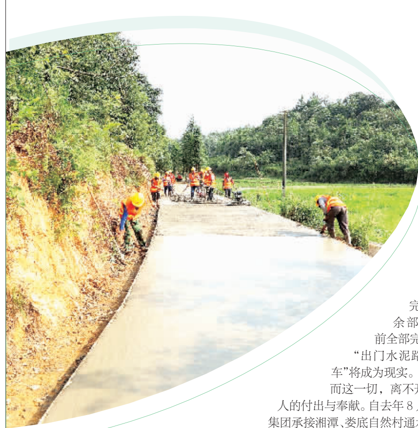
湖南交水建集团的建设者在湘潭县射埠镇涓江新村修筑水泥路。 易建东 摄
