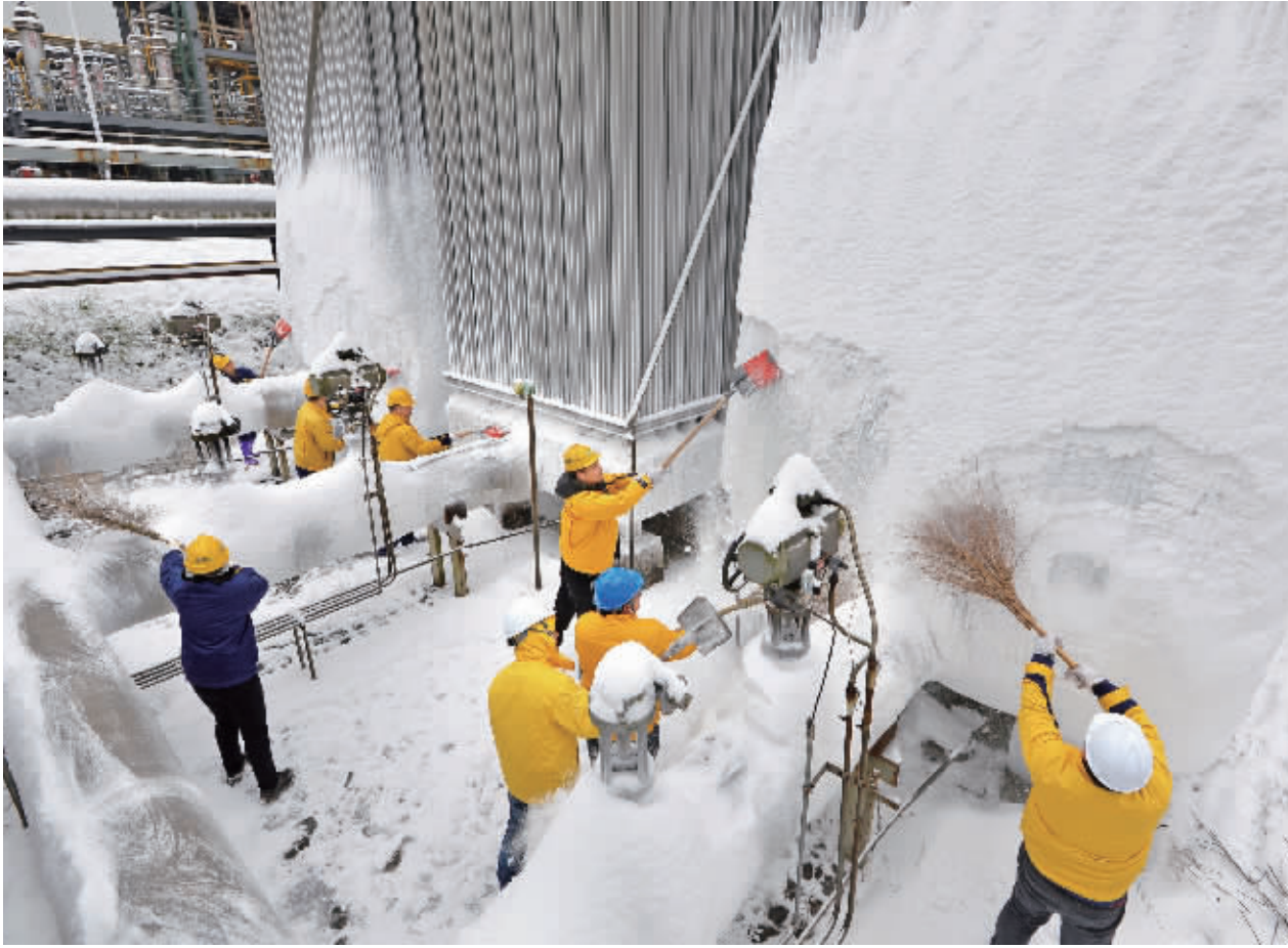
上图：2018年12月31日，长沙县望仙东路新奥燃气储配站内，工作人员对天然气供气设备进行铲冰除雪处理。当天，长沙新奥燃气开展“铲冰除雪”行动，确保管网运行安全，正常供应居民生活用气。
