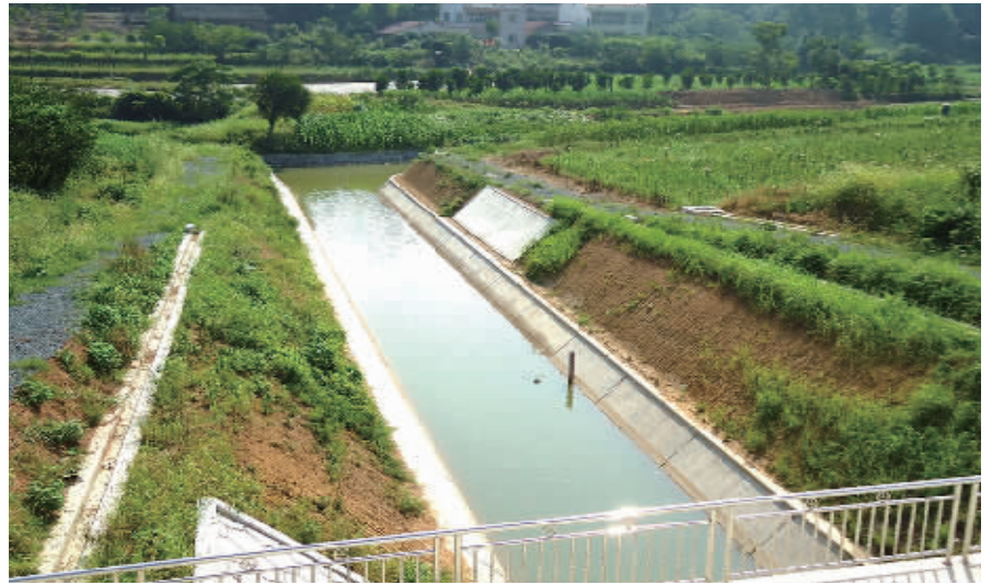
2018年改造后的黄石灌区北干渠。(本版图片均由湖南省水利工程项目局提供)
