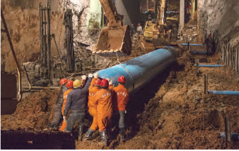
株洲市水务集团职工正在紧张抢修损毁水管。
