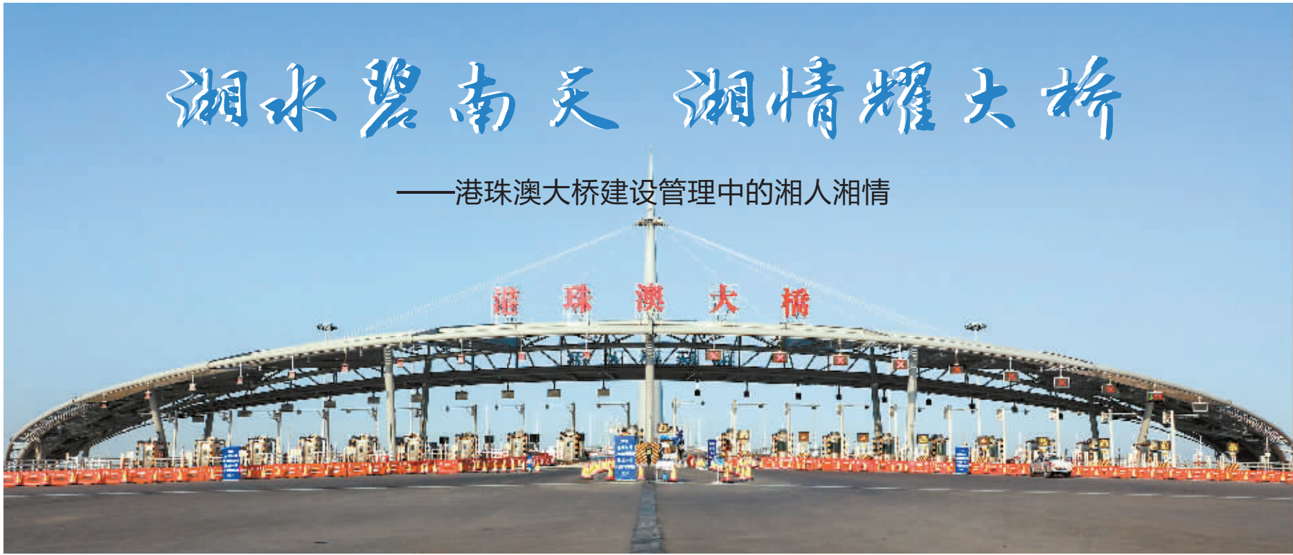
湖南建工修建的大桥珠澳收费大棚。（资料图片）
