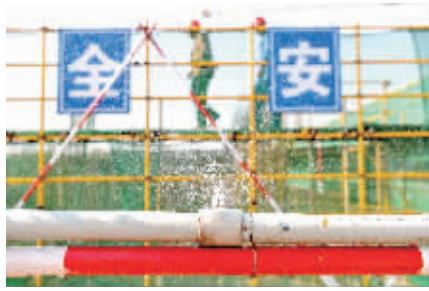
长沙市第七水厂新建厂区工地,喷淋系统正在降尘。
