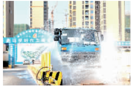
长沙市鑫远悦时代项目部,货车正通过全自动洗车器清洗车身泥土。
