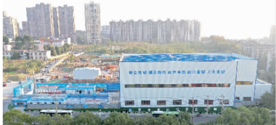
长沙市地铁6号线湘雅三医院站项目施工单位斥资400多万元,定制了一个长50米宽20米高19米的全封闭式防尘棚,极大地减少了扬尘和噪音对周边居民的影响。
