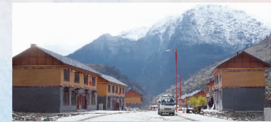
湖南建工集团承建西藏玉麦小康乡村建设项目。
