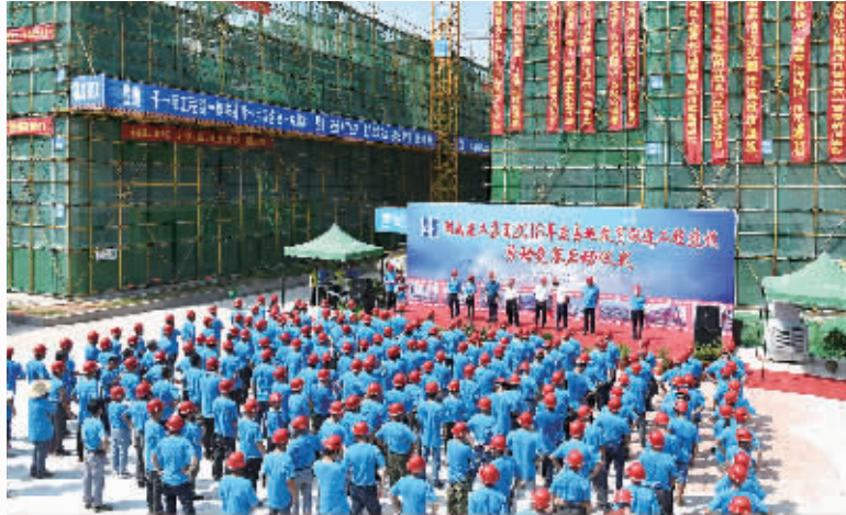
湖南建工集团积极推进全省易地扶贫搬迁项目建设。
