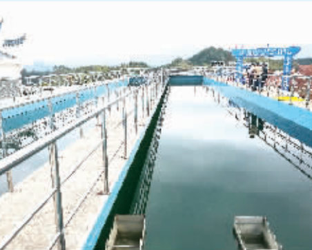
平江县供水枢纽工程沉淀池。该工程解决了大批贫困人口饮水安全问题。 资料图片
