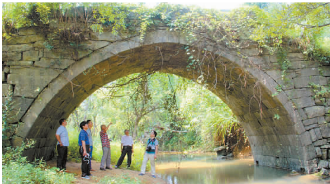
9月13日,永州市零陵区大庆坪乡,湘桂古道上的明代石拱桥。
