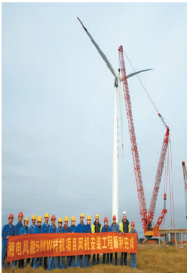
湘风能第一台5兆瓦直驱型永磁风电机组2012年初在福建省福清市沿海成功安装。(资料照片) 通讯员 摄
