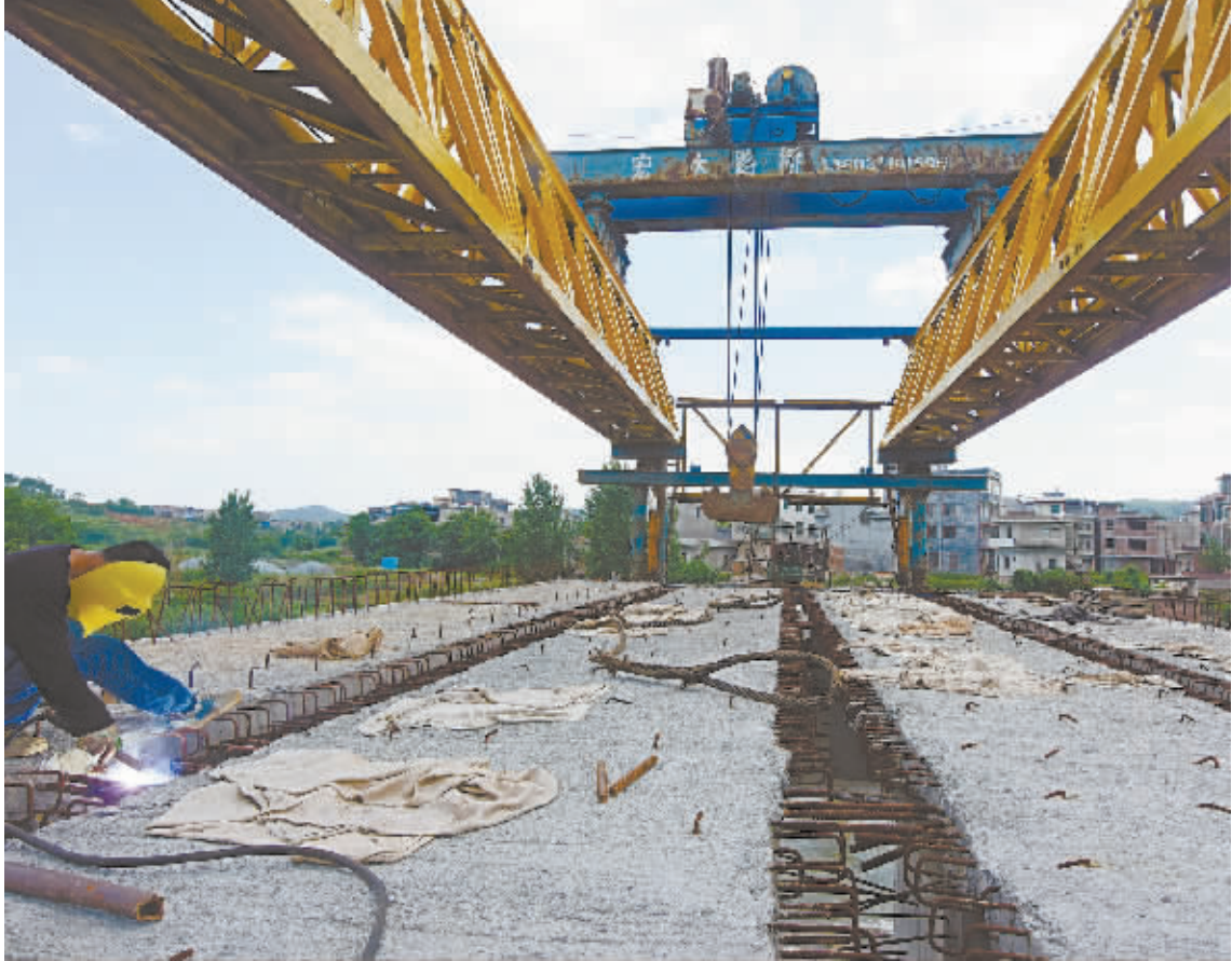
重建民生桥 5月15日,嘉禾县老麻地大桥重建工程,工人在架设预应力混凝土T梁。该桥服务周边五村的3000余名群众。2015年11月被洪水冲垮后,于2017年7月开工重建。新桥长282米,宽9米,预计今年底完工。黄春涛 摄
