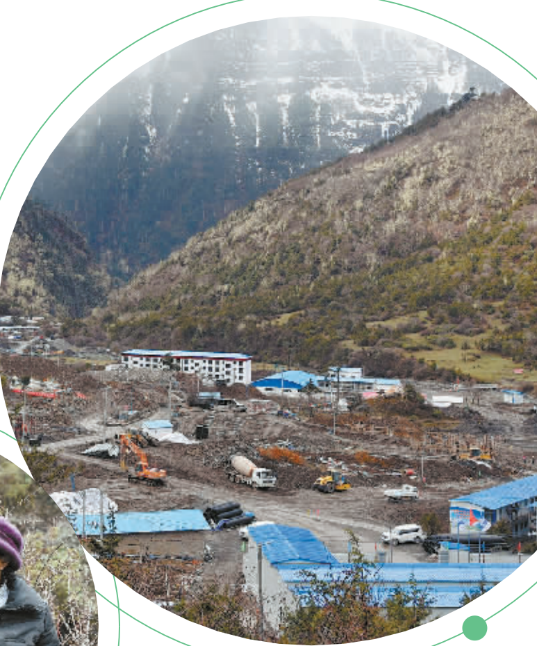
4月11日,湖南建工集团玉麦小康乡村建设项目现场。何力杰 摄
