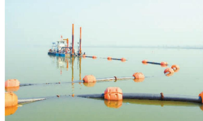
2月12日，安乡县珊珀湖，挖泥船在将湖底的淤泥吹填到8号湿地建设现场。 鲁融冰 摄
