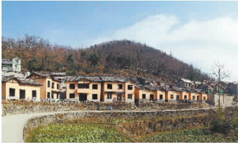
2月6日,正在建设中的雄龙村老寨易地扶贫搬迁房。 湖南日报记者 陈昊 摄
