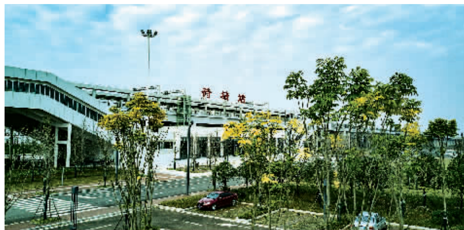
阳光下的城际铁路荷塘站
