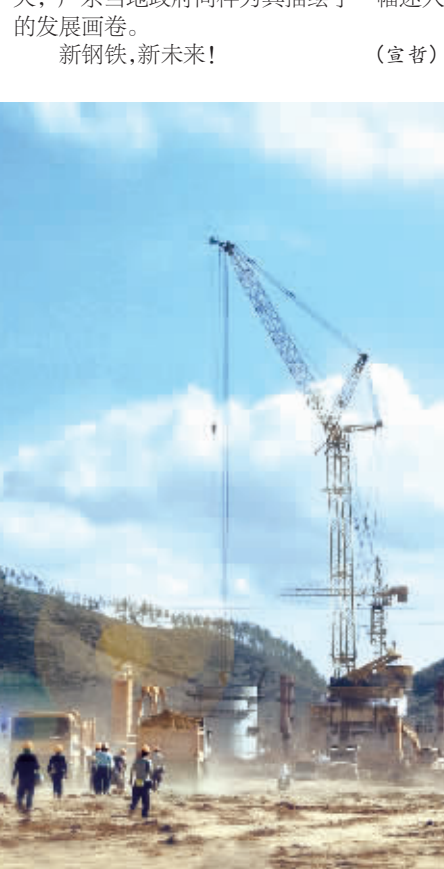
建设中的阳春新钢铁。 张卫国 摄
