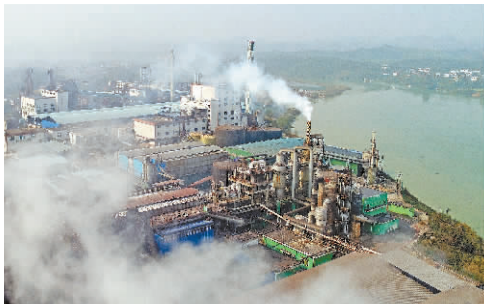
12月6日,郴州钨涛环保科技有限公司桥口分厂。
