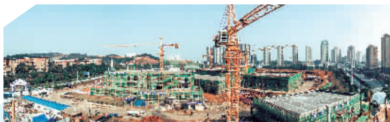
六水厂项目建设施工现场
