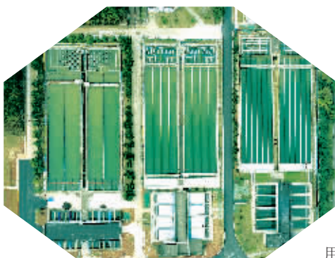
提质改造后的三、八水厂 童笛 摄
