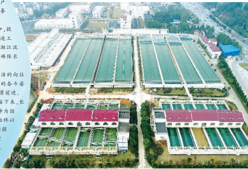
提质改造后的三、八水厂 童笛 摄
