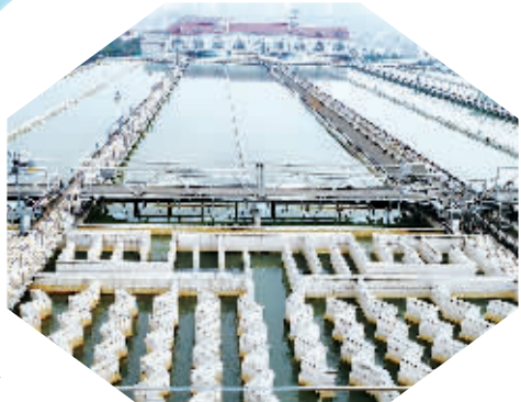
提质改造后的三、八水厂 童笛 摄
