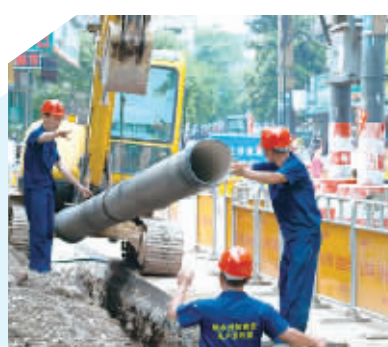
户表改造施工现场
