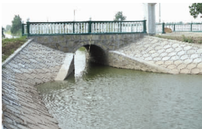
环洞庭湖基本农田建设重大工程君山区项目竣工后的机耕桥。
