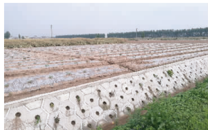
充分融入“生态理念”的农村土地整治项目,疏浚硬化的沟渠。
