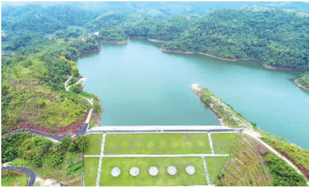
除险加固后的衡南县斗山桥水库。童迪 摄
