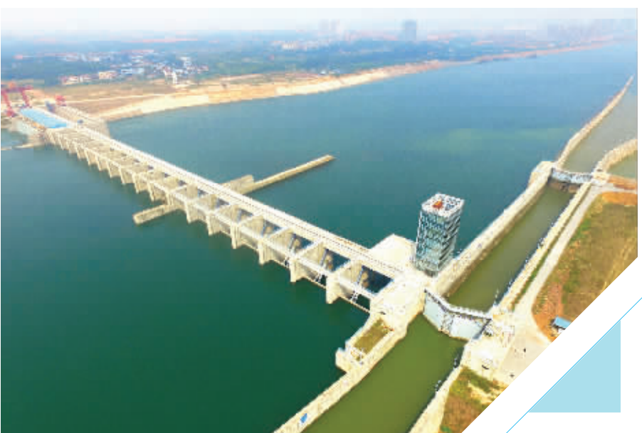
湘江土谷塘航电枢纽全面建成投产。
