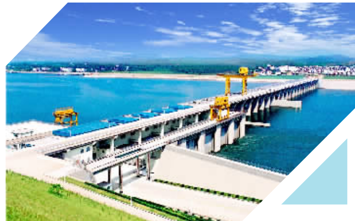
省水运投集团大源渡航电枢纽全景。
