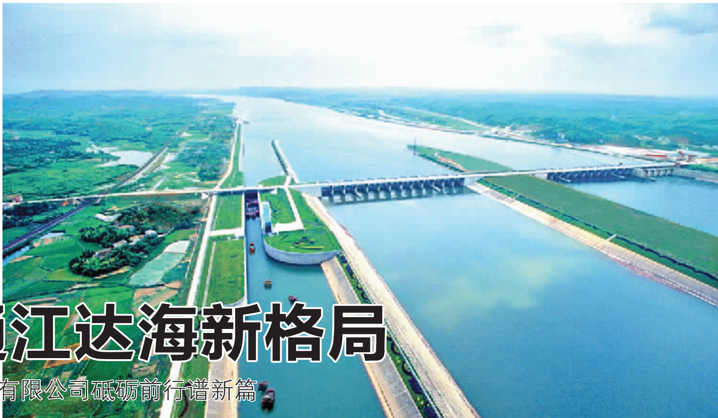
省水运投集团株洲枢纽一线船闸全景。
