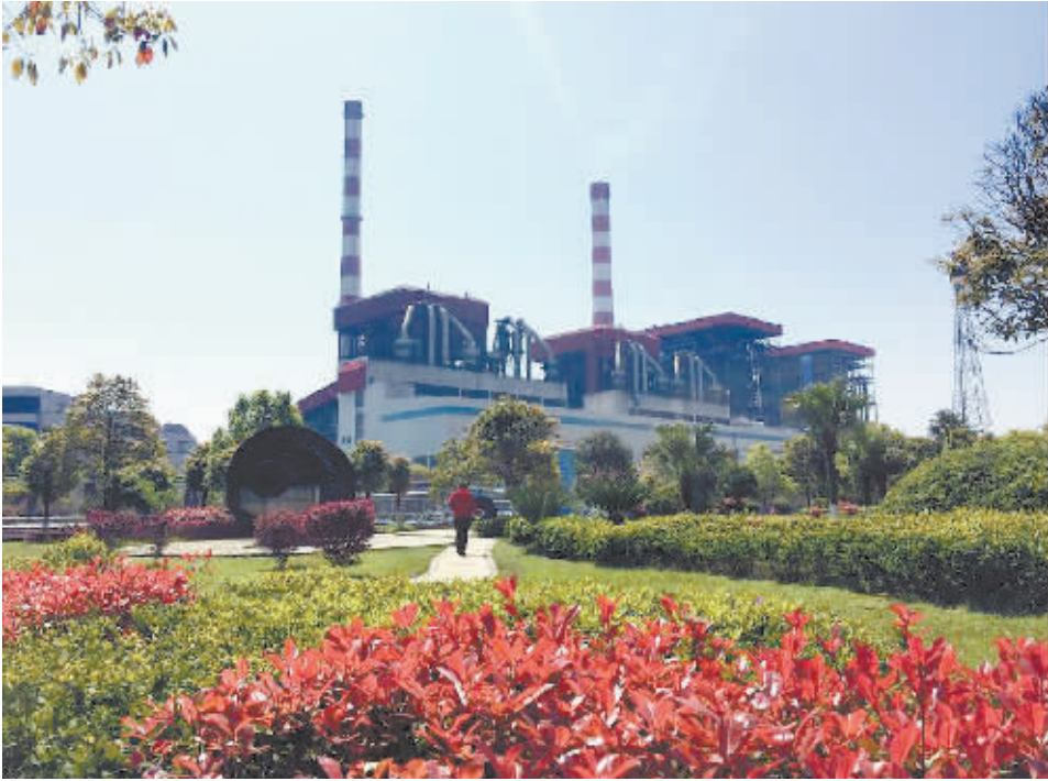
8月28日，大唐湘潭发电有限责任公司发电机组高负荷运行，为长株潭城市群输送电力。
