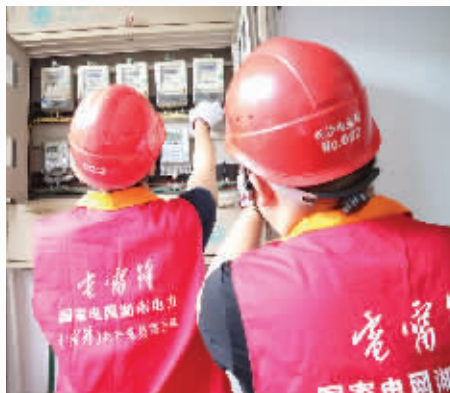
长沙电网员工进楼检修供电设备。
