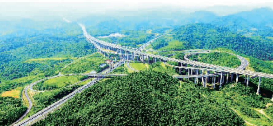
高速公路绿化——厦蓉高速与京珠高速交会处
