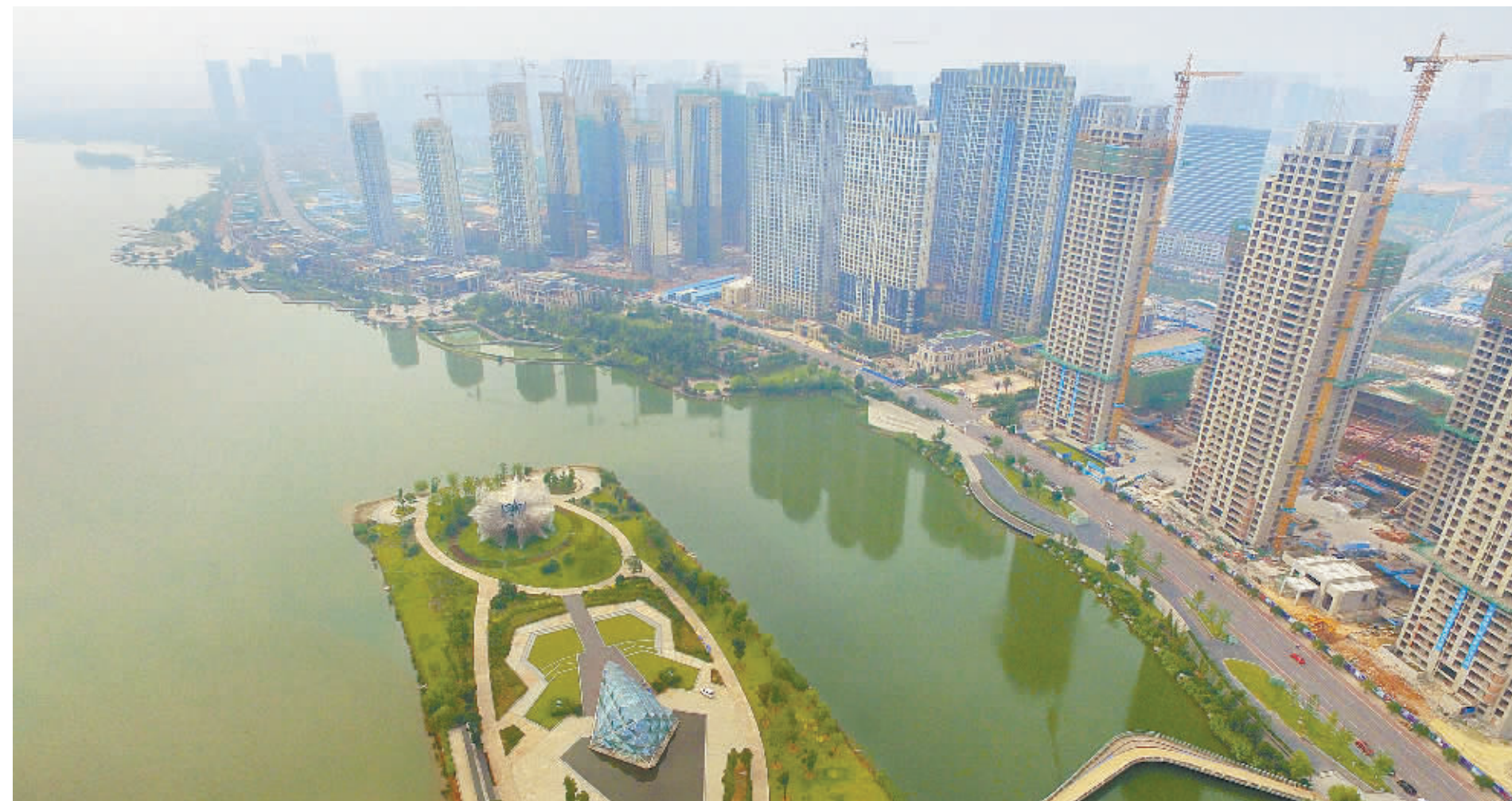
9月14日,长沙市湘江新区梅溪湖,正在建设中的梅溪湖未来城市中心。
