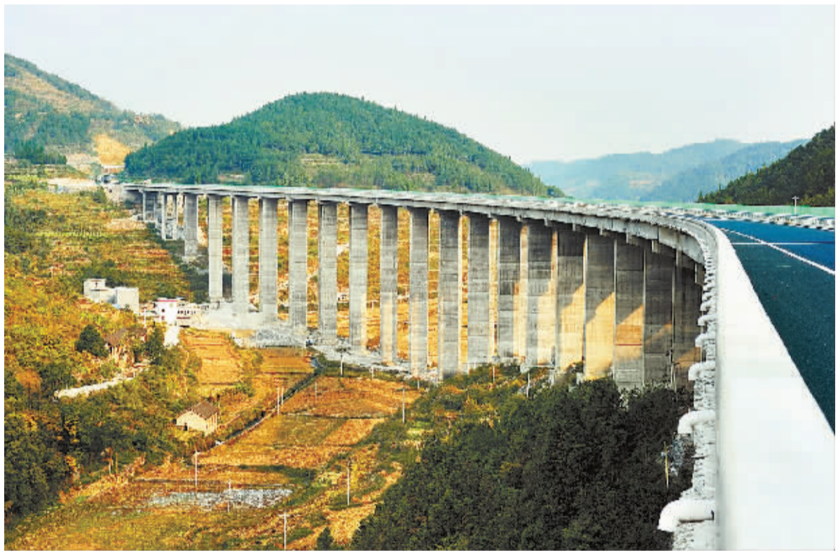
11月6日,凤大(凤凰至贵州大兴)高速公路建成通车,为湘黔两省和贵州省旅游再添新途。图为凤大高速公路把总湾大桥。
