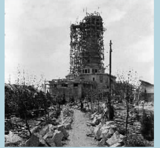
1959年4月5日，施工中的“湖南烈士公园纪念塔”。同年9月26日，纪念塔竣工。 唐又庭 摄
